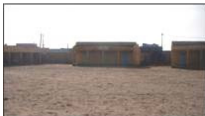
Interno della scuola elementare in un quartiere di Saint-Louis
